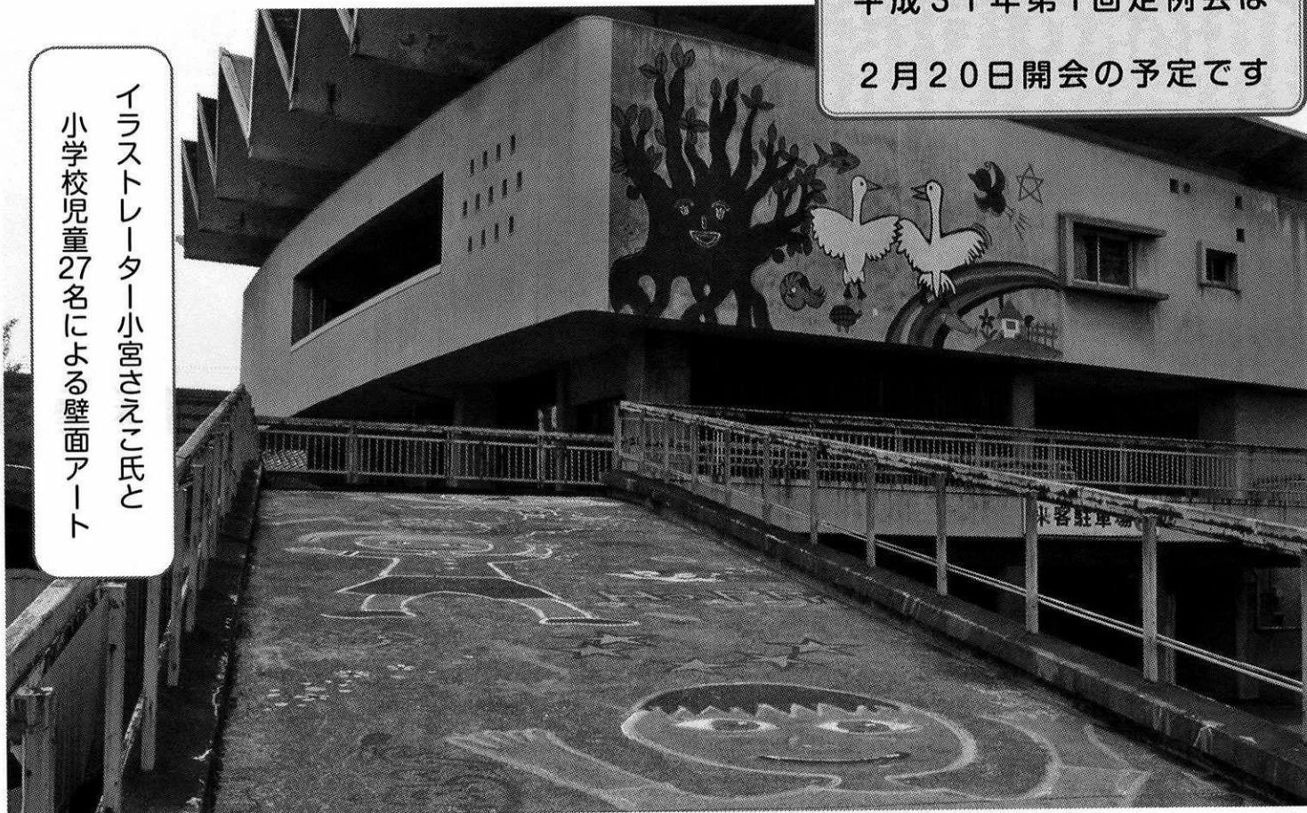
新庁舎建設のため解体する旧市民会館（現和泉市役所5号館）
