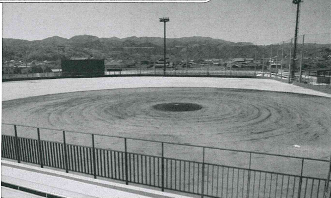
7月2日にオープンした和泉市総合スポーツセンター「野球場」（下宮町）
