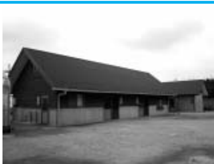
建設中の農業体験交流施設
